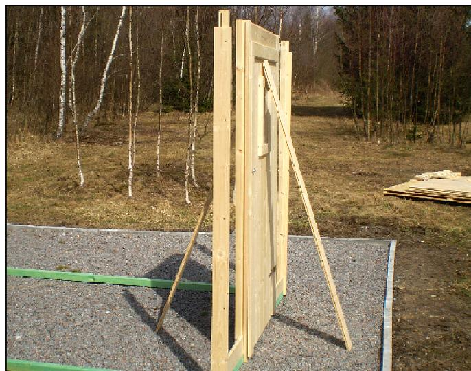
Obrázek 10: Zajištění panelu proti pádu
