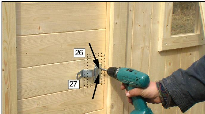
Obrázek 27: Petlice dveří, použité vruty 3,5x25 mm
