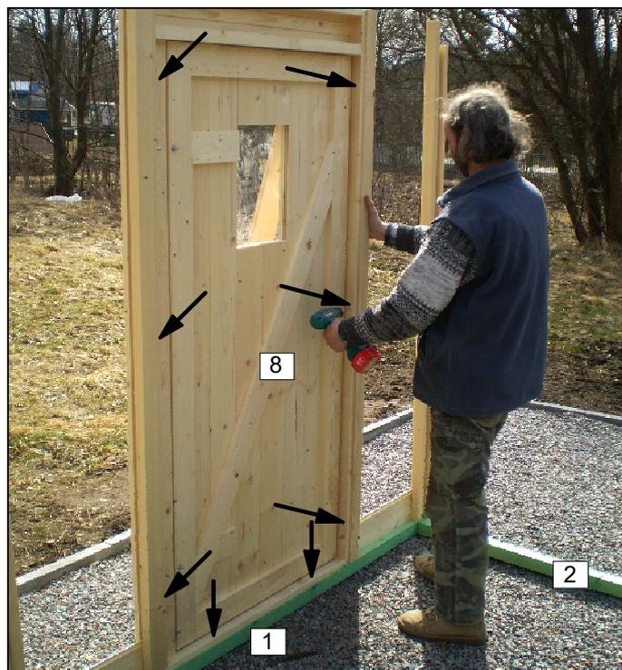
Obrázek 9: Montáž dveřního panelu, použité vruty 4x40 mm
