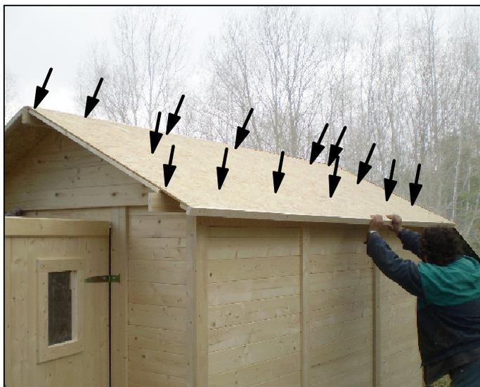
Obrázek 24: OSB střecha, použité vruty 4x40 mm
