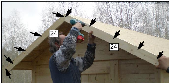
Obrázek 25: Štítová prkna, použité vruty 4x50 mm
